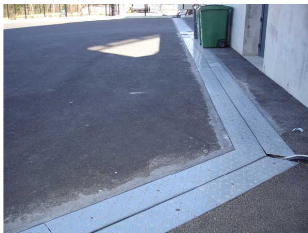
Camions satellite orientés vers le SUD Passage de câbles sous Terrain - Mise en sécurité des câbles
