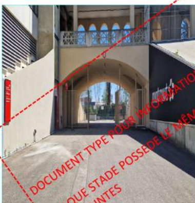
ESPACE DE STOCKAGE SECURISÉ POUR LES 9 PALETTES DE MATÉRIEL DURANT LA SEMAINE DE REMISE À NEUF
